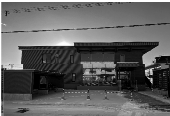
写真1 北見市西部地区公民館外観
