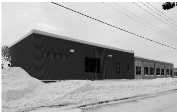
写真10 増築部分外観
